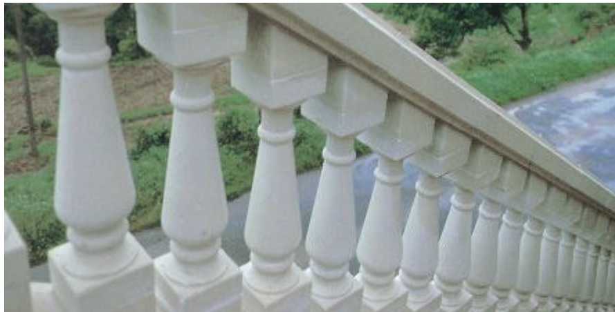
PARTICOLARE BALAUSTRA CON CUNEO CBLR-2 PER SCALINATE
